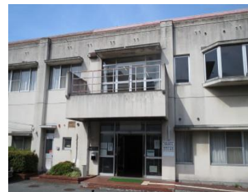
勤労青少年ホーム（昭和55年建設 築36年）
