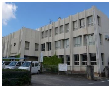
南公民館（昭和49年建設 築42年）
