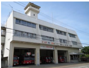
消防庁舎（昭和44年建設 築47年）
