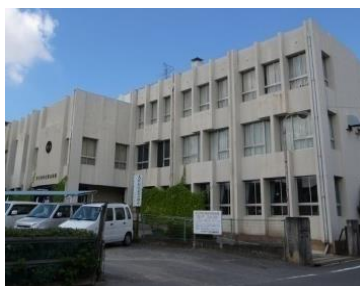
南公民館(昭和 49 年建設 築 52 年)
