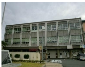
職員会館(昭和 45 年建設 築 56 年)
