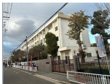
穴師小学校校舎(昭和 47 年建設 築 54 年)
