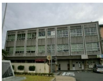
職員会館(昭和 45 年建設 築 56 年)
