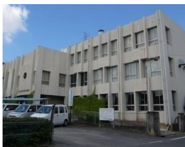
南公民館(昭和 49 年建設 築 52 年)
