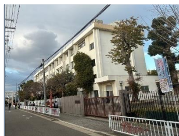
穴師小学校校舎(昭和 47 年建設 築 54 年)
