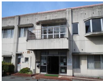
勤労青少年ホーム(昭和 55 年建設 築 46 年)
