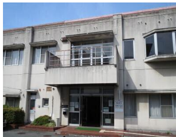
勤労青少年ホーム（昭和 55 年建設 築 46 年）
