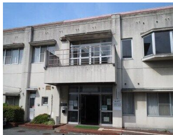
勤労青少年ホーム（昭和55年建設 築46年）
