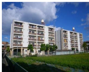
二田市営住宅
