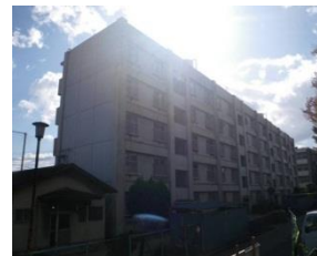
助松市営住宅
