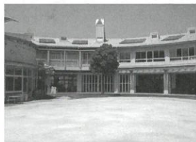
平成11年に建てられた園舎
