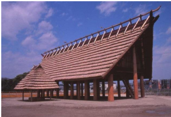
写真 5-8 大型掘立柱建物
