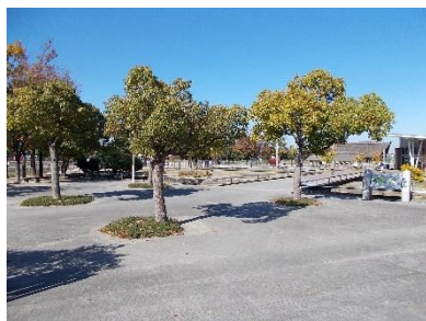
写真 5-43 インターロッキング舗装(入口広場)
