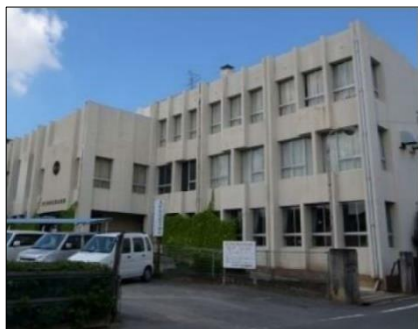
南公民館(昭和49年建設)
