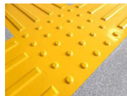
■ 警告ブロック
