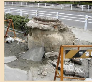
出典：財団法人消防科学総合センター 東日本大震災 液状化により浮き上がったマンホール被害の様子
