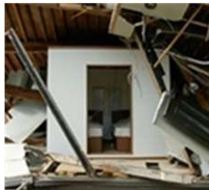
(耐震シェルターの例)
