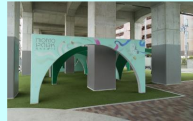
地域生活基盤施設 高架下広場
