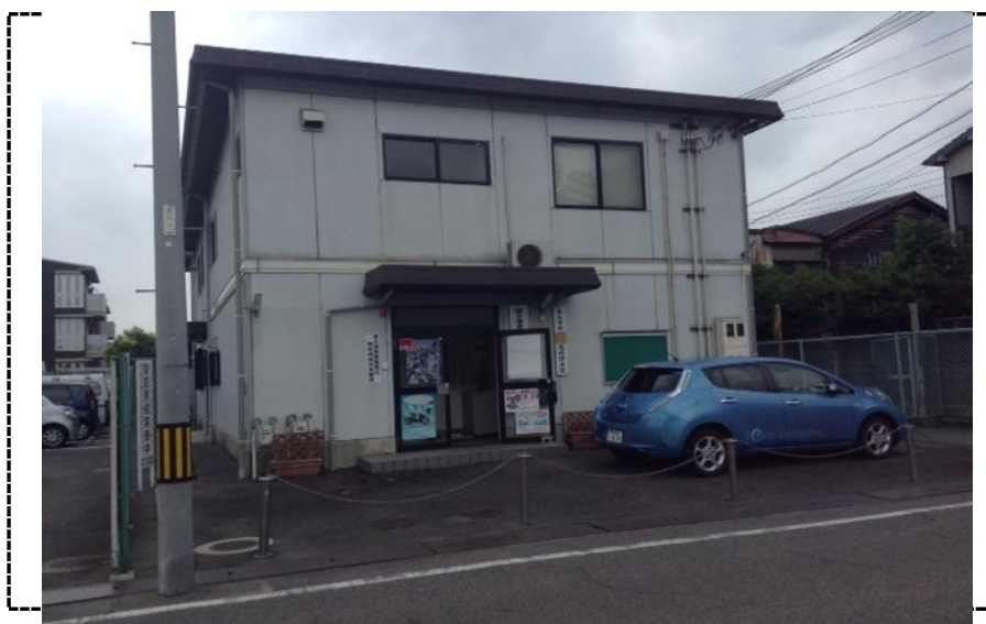
建物全景 写真
