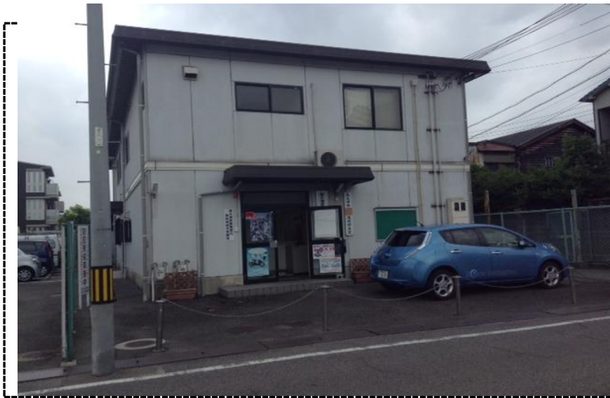
建物全景 写真
