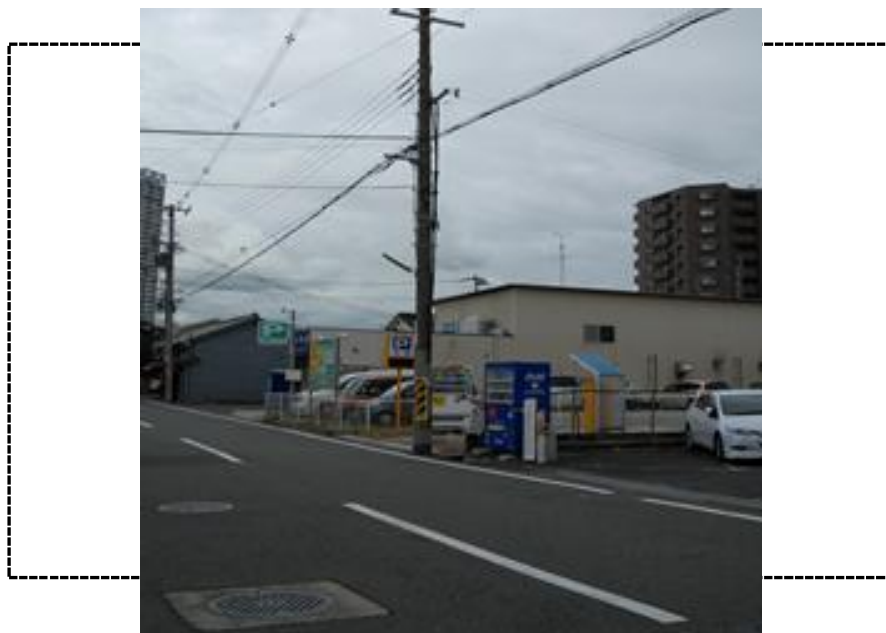
建物全景 写真
