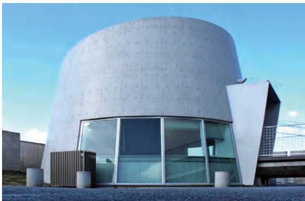
改修工事で竣工当時の肌合いがよみがえった 展示ホール
