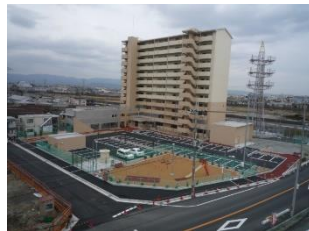
河原町市営住宅 ※平成 26 年 2 月に竣工した新河原町市営住宅
