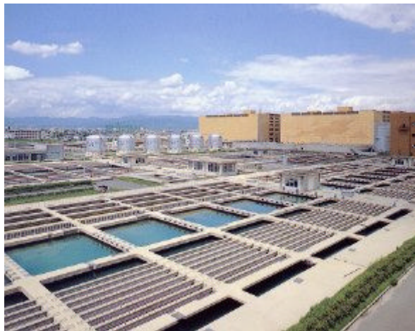
大阪広域水道:村野浄水場（枚方市）
