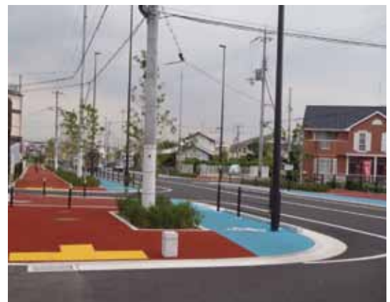
整備後の南海中央線(森地区)
